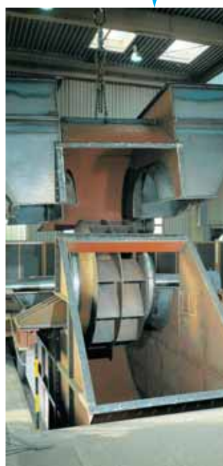
Пробный монтаж двухпоточного центробежного вентилятора
